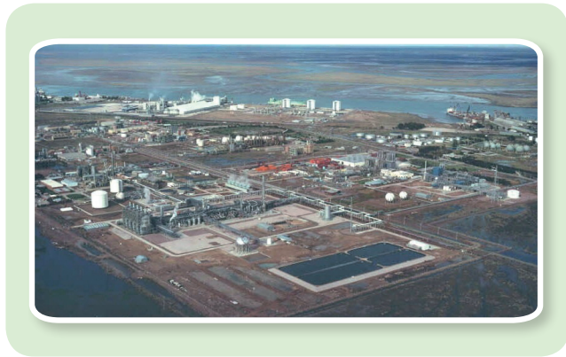
El Complejo Bahía Blanca opera desde 1995. Lo integran 6 plantas productivas: 2 plantas de etileno y 4 de polietileno, que producen polietileno de baja densidad (LDPE), alta densidad (HDPE) y lineales (LLDPE y EPE).
