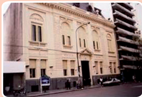
Fachada del edificio donde funciona el colegio Mariano Moreno, que albergó al Joaquín hasta su mudanza definitiva
