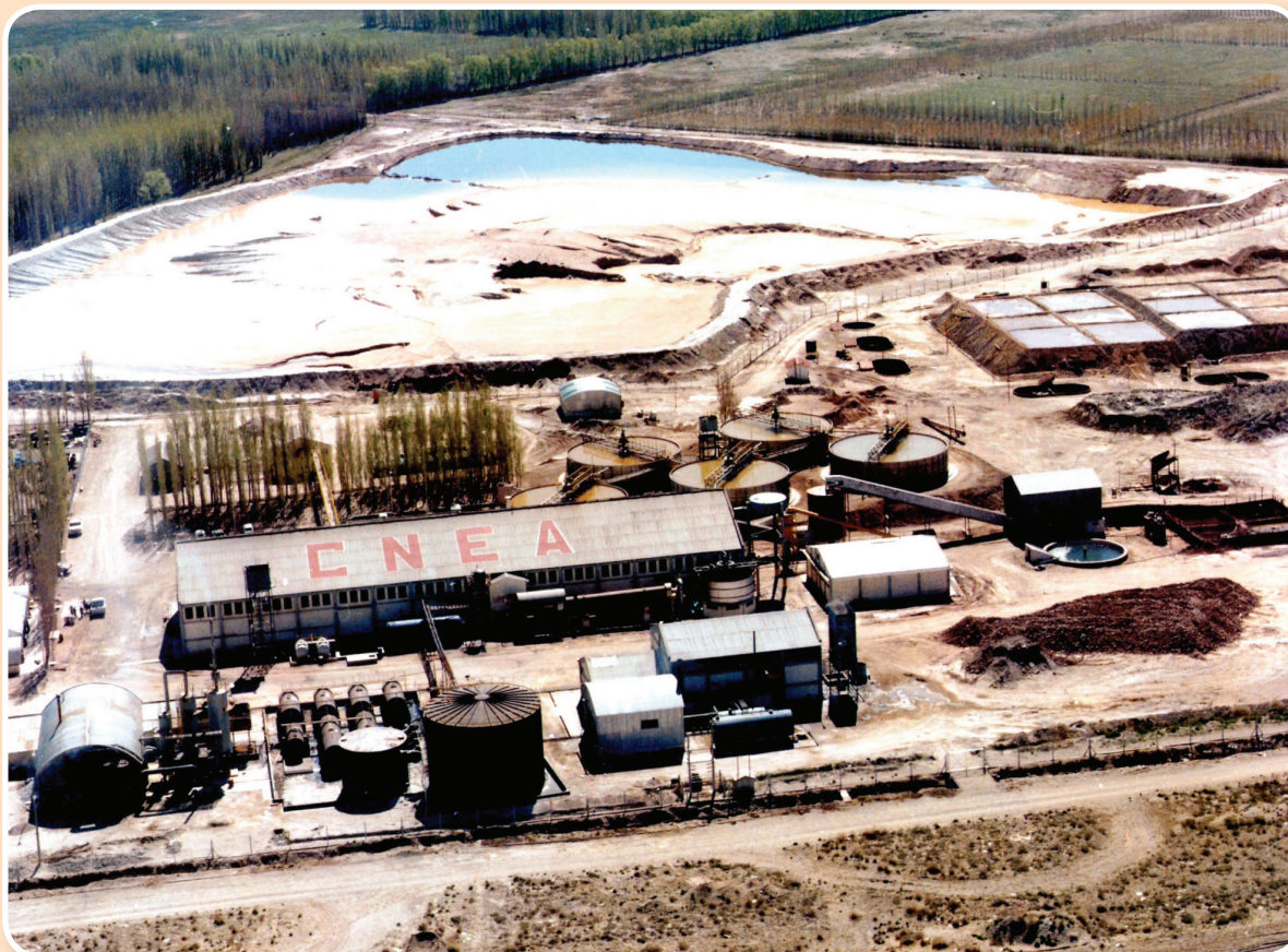
Figura 3: Foto aérea de la Planta Malargüe.
