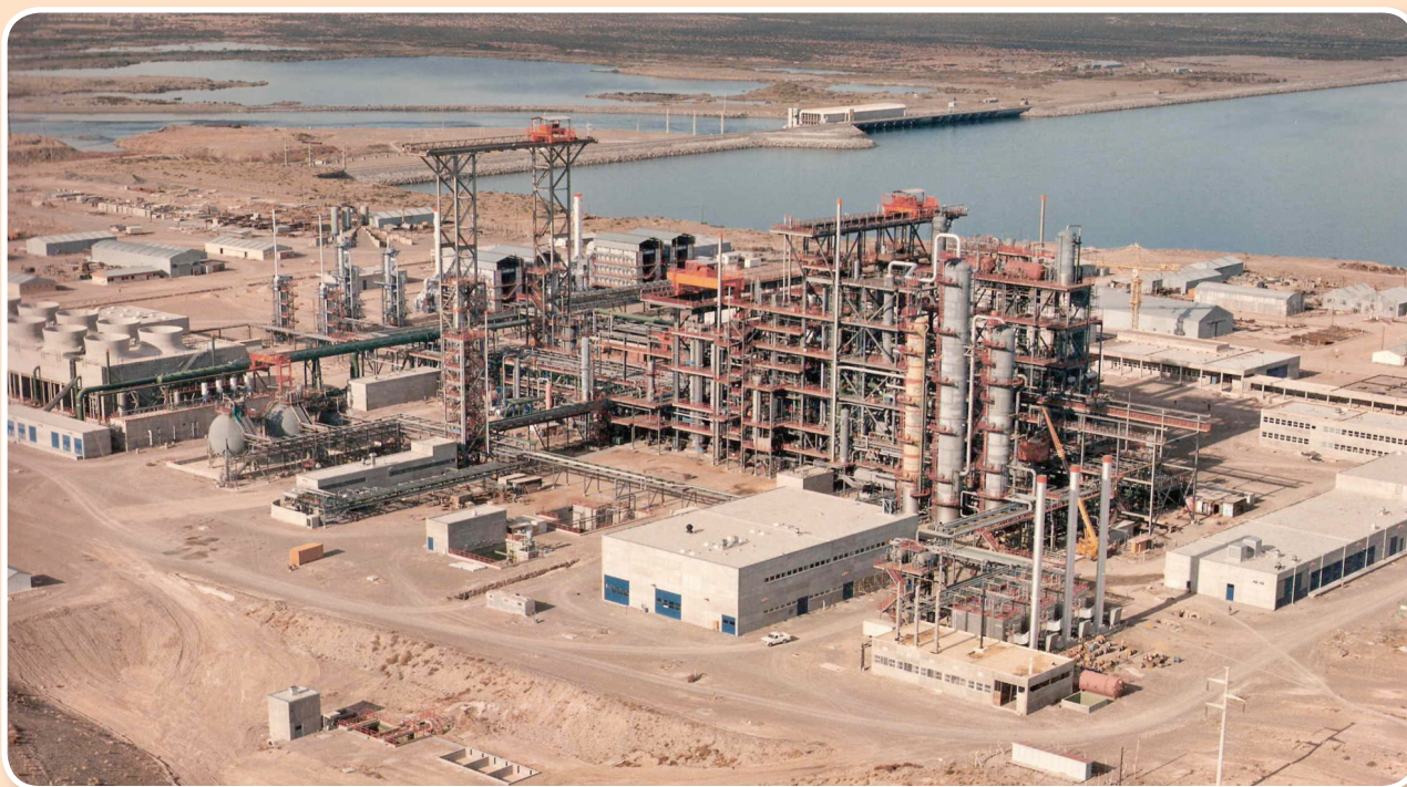
Figura 3: PIAP en construcción - Dique compensador de Arroyito al fondo.
