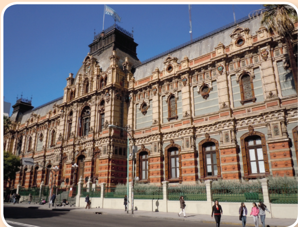
Imágenes del edificio del Palacio de las Aguas Corrientes, Av. Córdoba al 1900, Ciudad de Buenos Aires.
