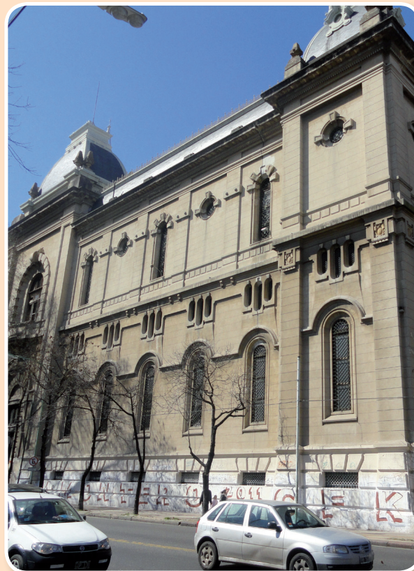
Fachada exterior del edificio de depósito de agua de Villa Devoto (Av. Beiró y Mercedes) en la Ciudad de Buenos Aires.
