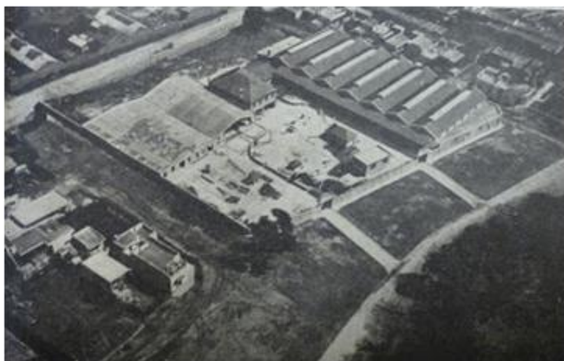
Figura 7. Vista aérea de la bulonera Máspero.
