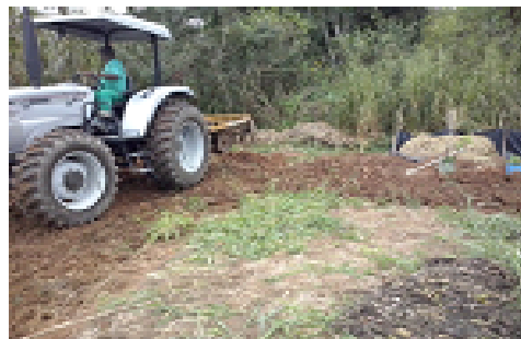
Fig. 2 Preparo dos blocos
